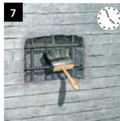
**7** Korrosionsschutz der Bewehrung
