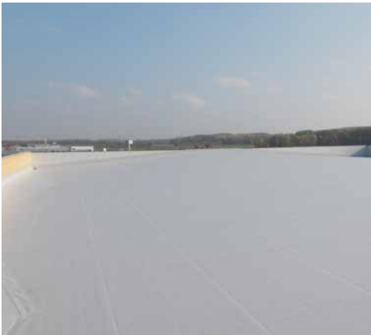
Bild 5: Mittels Gefällezeugen wurde ein Quergefälle zu den Abläufen hergestellt
