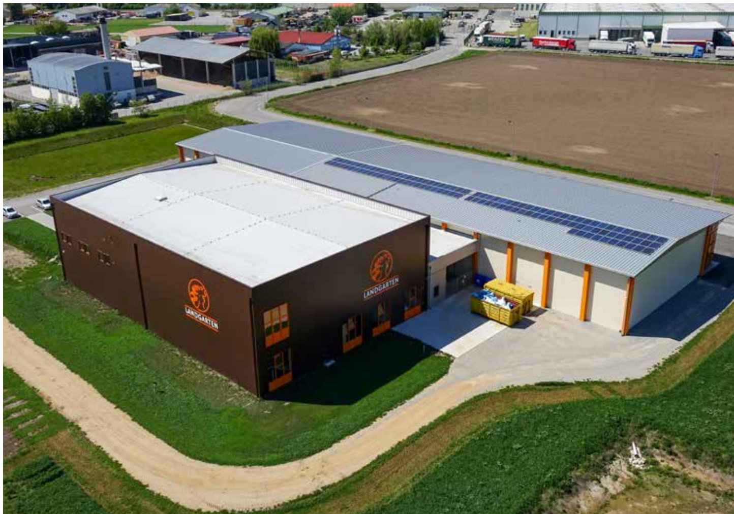
Bild 7: Das Satteldach ist vom Boden aus nicht zu erkennen
