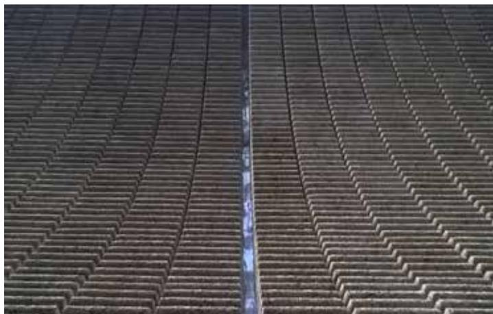
Bild 2: Insgesamt wurden 580 Fugen zu je 10 lfm hergestellt
