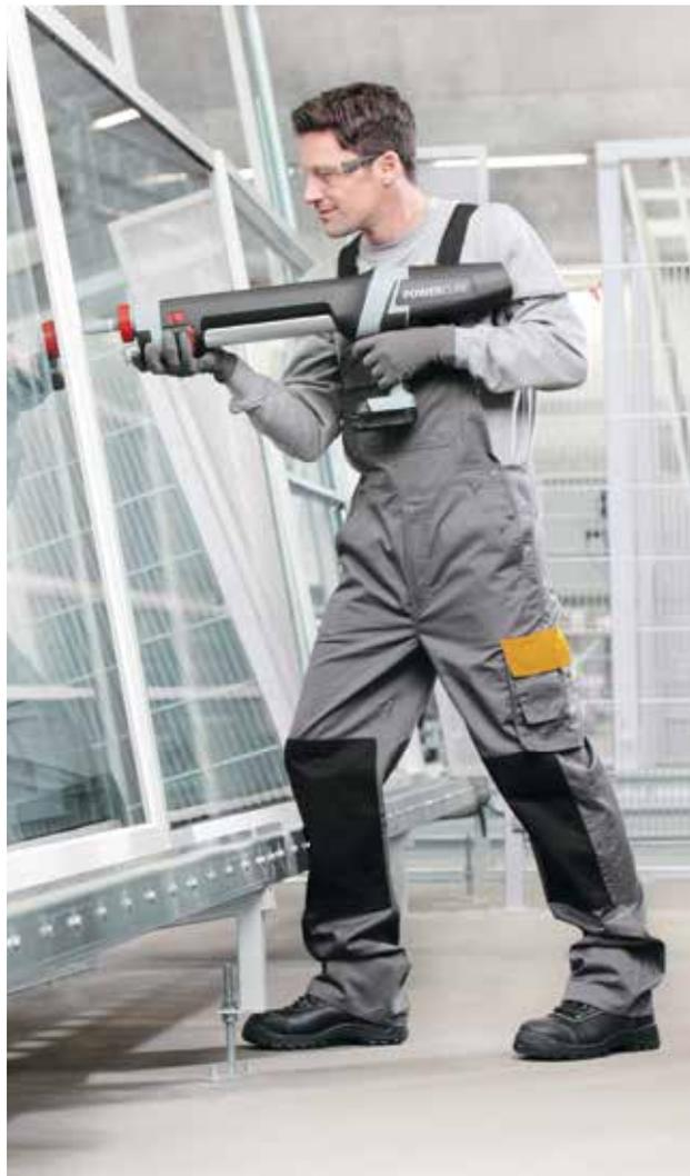
Manuelle Verbindung von Fensterrahmen und Isolierglas-
