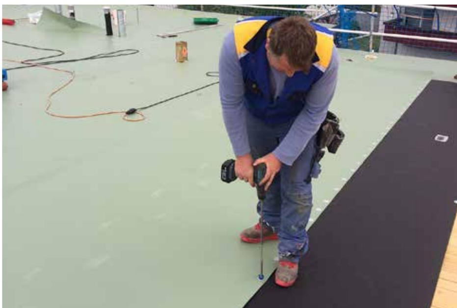
Fixierung der Kunststoffdichtungsbahn auf darunterliegenden Aufbau mittels SFS ISOFAST Kombi TS
