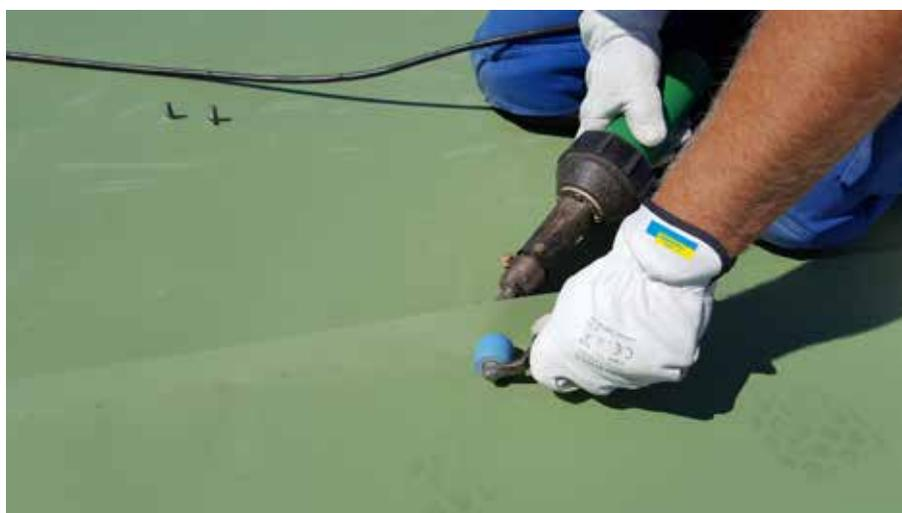
Keine offene Flamme bei der Montage durch Heißluftverschweißung
