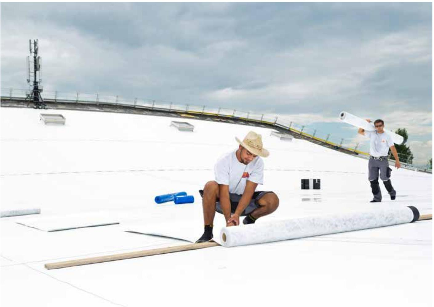
Die Dachabdichtung Sarnafil® TG 76-20 Felt PS in der Sonderfarbe RAL 9016 verkehrsweiß ermöglicht die Sika Cool Roof Technologie
