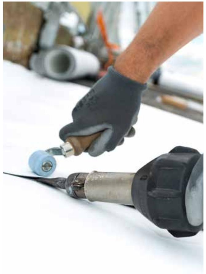
Thermisches Heißluftverschweißen am 8 cm breiten Schweißrand
