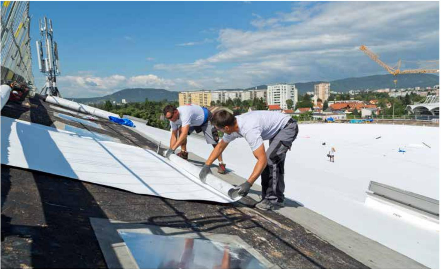
Vollflächige Verklebung der vlieskaschierten Dachbahnen mittels Sarnacol®-2142 S
