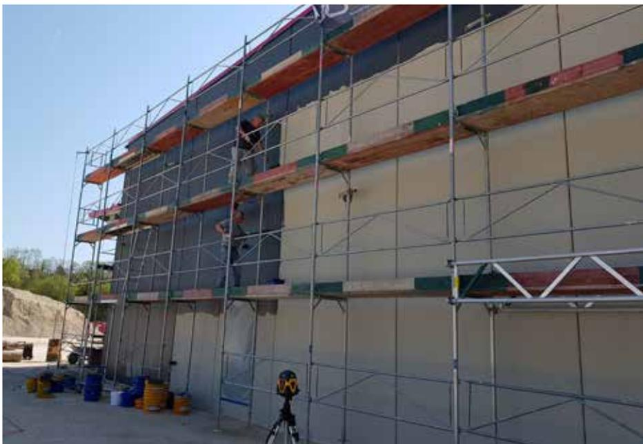
Nach Einrüstung der gesamten Wandfläche konnte mit der Sanierung der Fassade begonnen werden
