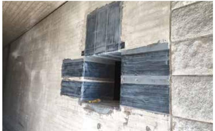
Bild 3: Fertiggestellte Verstärkungsmaßnahme mit SikaWrap®-301 C
