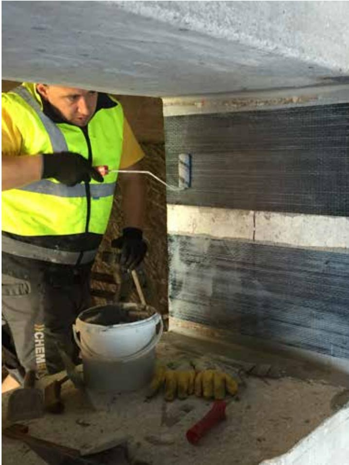
Bild 1: Applikation des CFK-Gewebes mit Imprägnierharz
