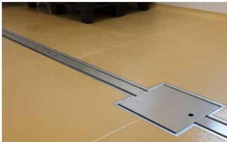
Bild 2: Abläufe und Ringolen werden plan in den Boden integriert
