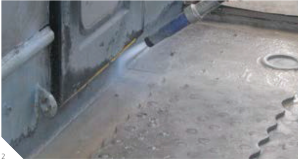
Abb. 2: Sandstrahlen
