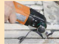
Fig. 3 Entfernen der Dichtfugen
