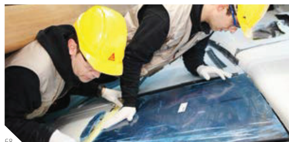
Abb. 68: Auftrag von Sikaflex®-296
