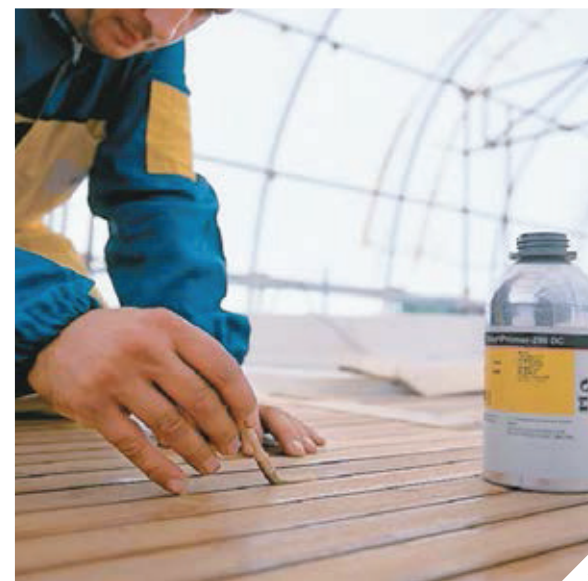
Abb. 17: Sorgfältiges Aufbringen von Sika® Primer-290 DC
