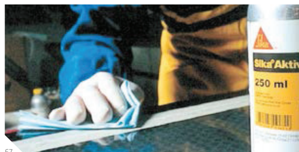
Abb. 67: Auftrag von Sika® Aktivator
