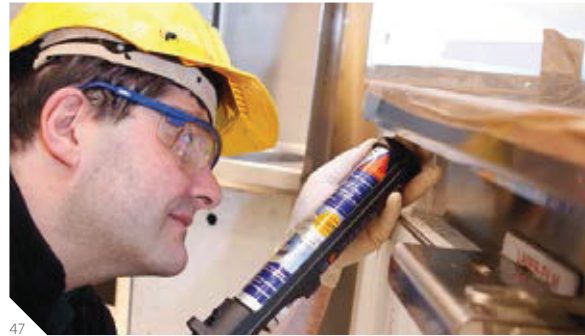
Abb. 47: Auftrag von Sikaflex®-292i
