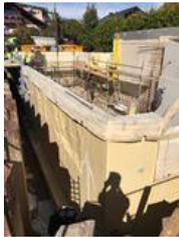
Dauerhafte Abdichtung der Kelleraußenwände (ca. 350 m<sup>2</sup>) durch das SikaProof® A Abdichtungssystem
