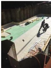
Horizontalabdichtung unter der Fundamentplatte durch SikaProof® A
