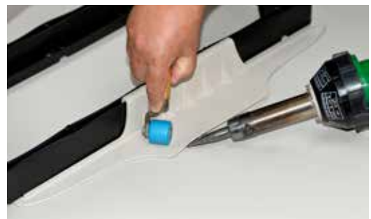
Bild 4: Handschweißung auf der ganzen Länge und Tiefe
