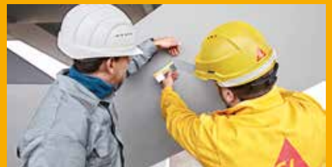
SERVICE UND BERATUNG AUF DER BAUSTELLE
