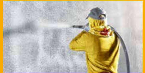
BETONSCHUTZ UND INSTANDHALTUNG
