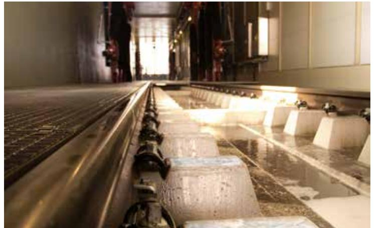
Bild 4 - Auffangwanne der Gleisanlage für die Reinigungsreagenzien
