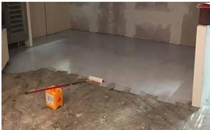
Bild 1: Grundierung der Bodenfläche durch Auftrag von Sikafloor®-156
