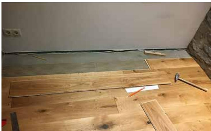
Bild 3: Mit SikaBond®-152 Dispenser werden die Holzdielen vollflächig verklebt
