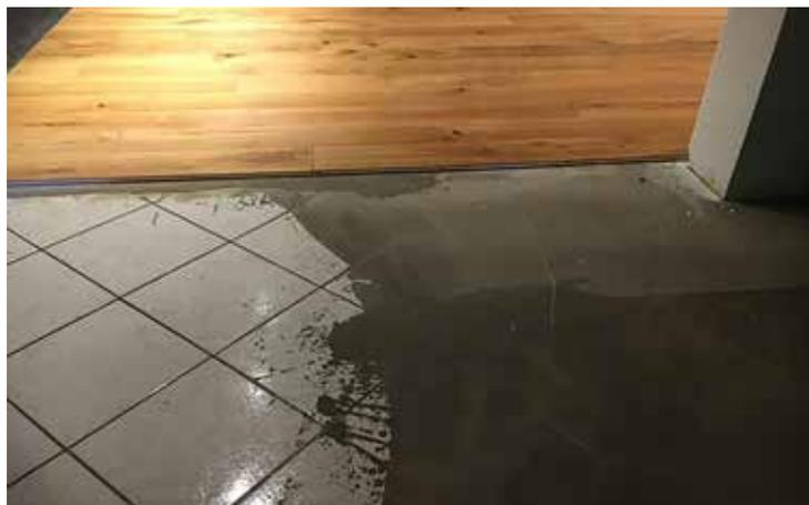
Bild 2: Die Nivelliermasse Sika® Level-100 AT schafft den nötige Ausgleich auch über Keramikfliesen
