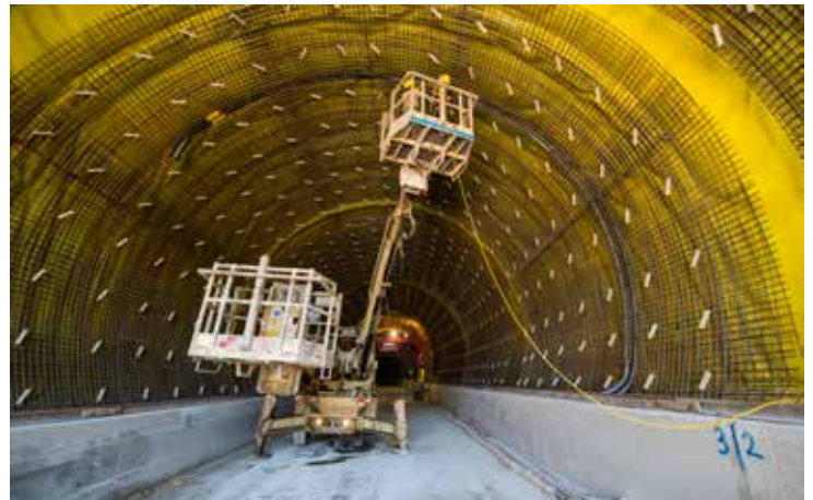
Bild 4: Abdichtung und Bewehrung vor dem Betonieren der Innenschale
