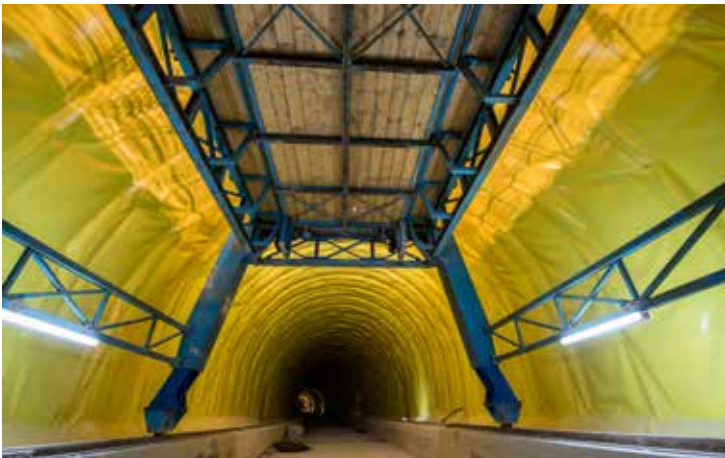
Bild 3: Fahrbares Gerüst zur sicheren Verarbeitung
