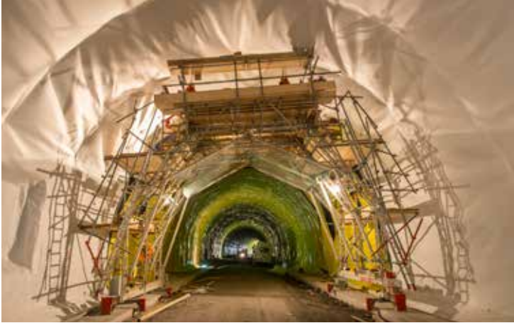
Bild 1: Sauber gearbeitete Vliesunterlage ermöglicht die Folienanbringung
