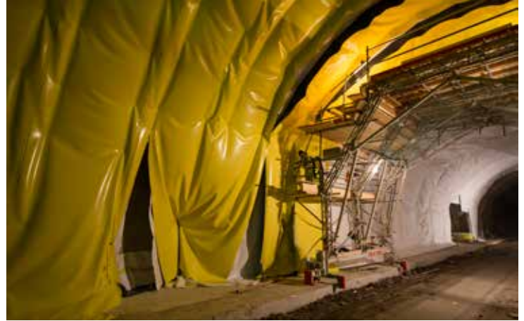
Bild 2: Aufschweißung der Folienbahnen an den Rondellen (Trägerscheiben)
