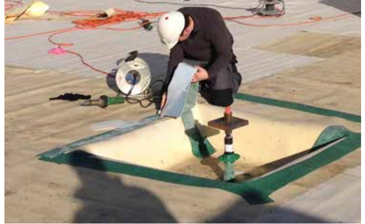
Bild 2 - Auftriebssicherung in der Bodenplatte
