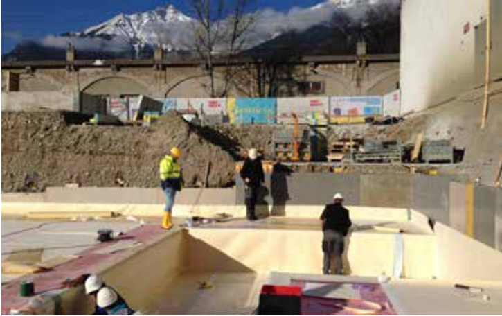
Bild 1 - Verlegung von SikaProof A auf die Wärmedämmung
