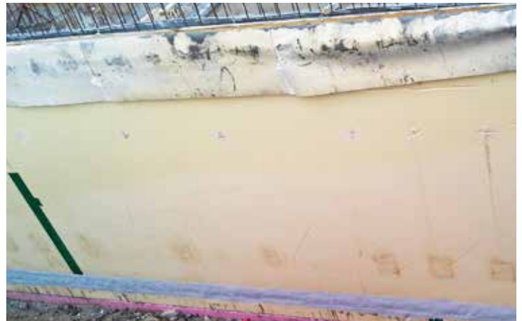
Bild 4 - Abdichtung des Anschlusses Bodenplatte - Wand mit Sikadur® Combiflex
