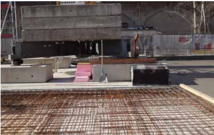
Bild 3 - Frischbetonverbundfolie unter der Bewehrung
