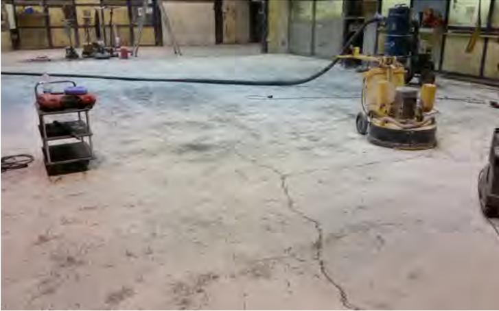
Bild 1: Vorbereitung des Untergrundes durch fräsen und verharzen der Risse
