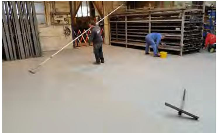
Bild 4: Auftrag von Sikagard®-916 Hybrid im Kreuzgang
