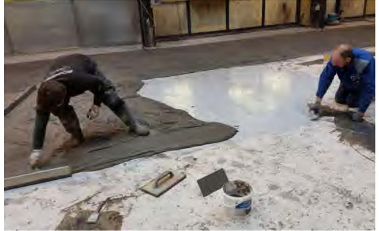
Bild 2: Grundierung und Einbau des Materials SikaScreed® HardTop-60
