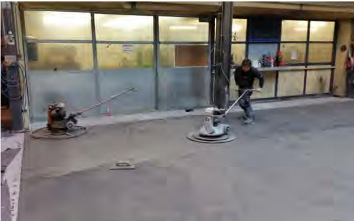
Bild 3: Fertig abgezogene Fläche glätten und flügelglätten
