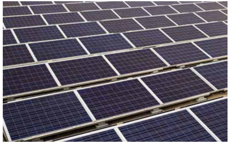
Bild 3 - PV-Module mit Südausrichtung und 15° Neigung
