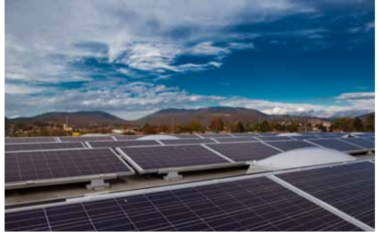
Bild 2 - Blick über die Dächer der Werkstätte und Ausstellungshalle
