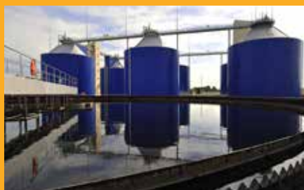
Schutz und Instandsetzung vom Beton
