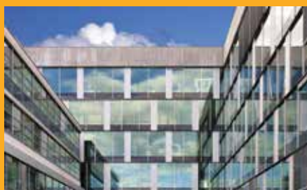
Kleben und Dichten im Fassadenbereich
