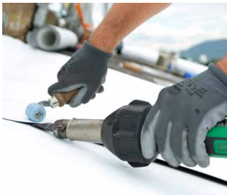
Bild 7: Thermisches Heißluftverschweißen am 8 cm Schweißrand
