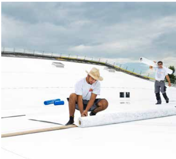
Bild 5: Flächige Dachabdichtung mit Sarnafil® TG 76-20 Felt PS
