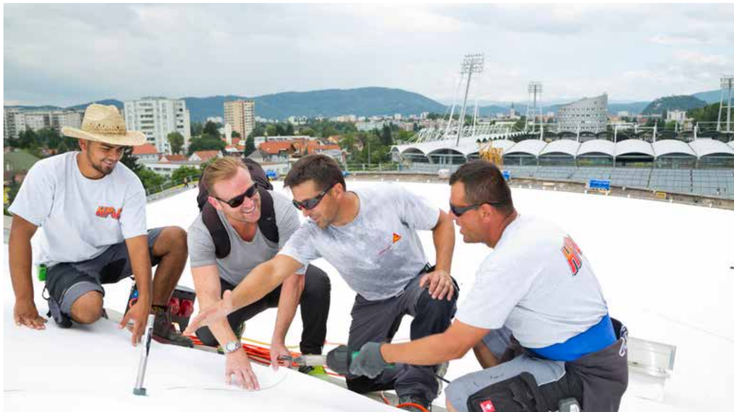
Bild 8: Sika Sarnafil® Support auf der Baustelle
