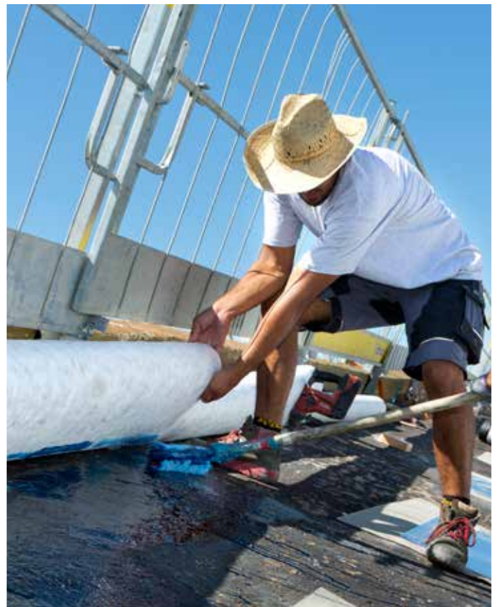
Bild 3: Vollflächige Verklebung der Membranen
