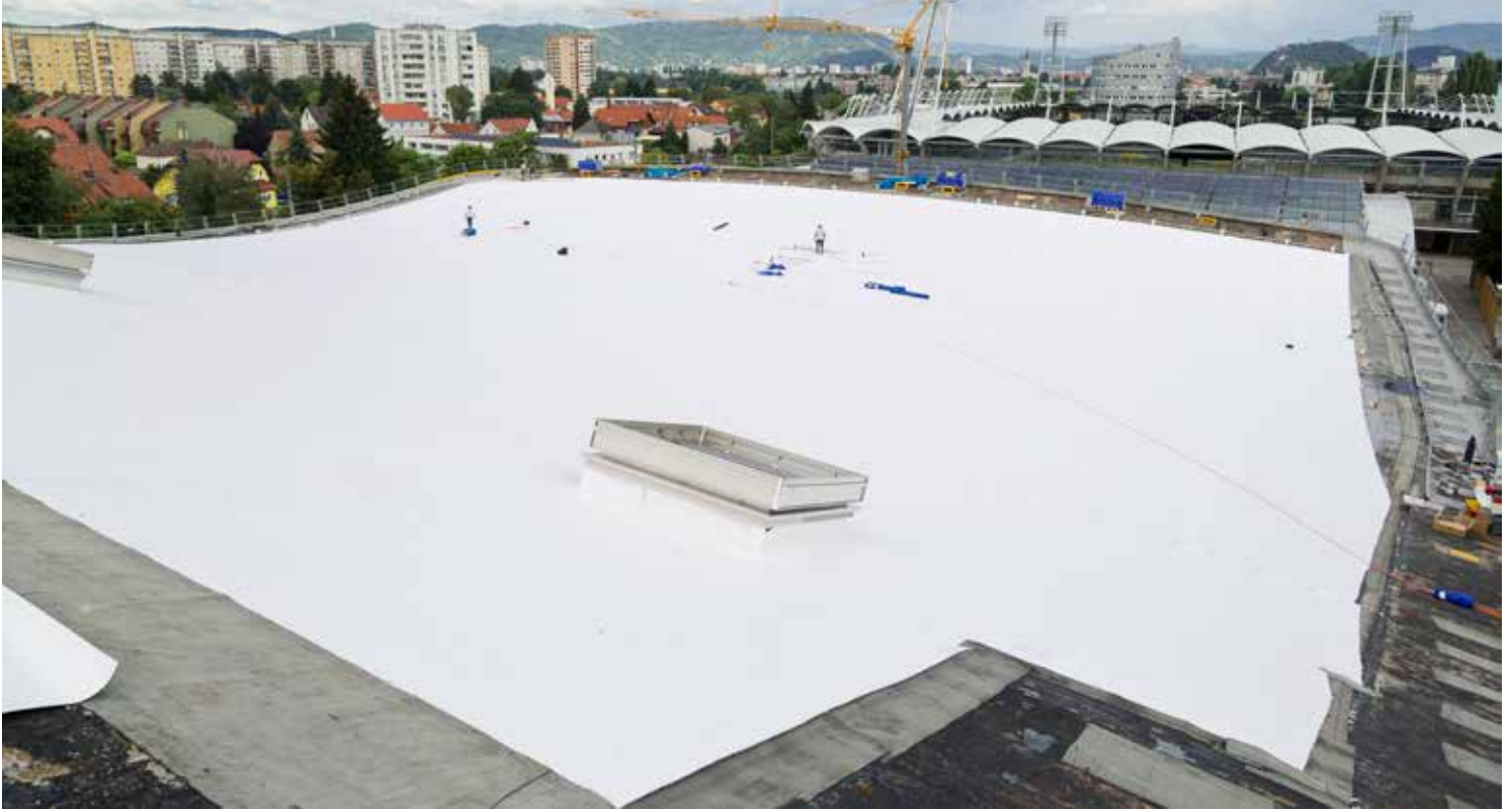
Bild 1: Bestehende Bitumenbahnen mussten zusätzlich befestigt werden
