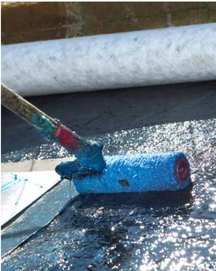
Bild 2: Aufbringen des Klebers Sarnacol®-2142 S
