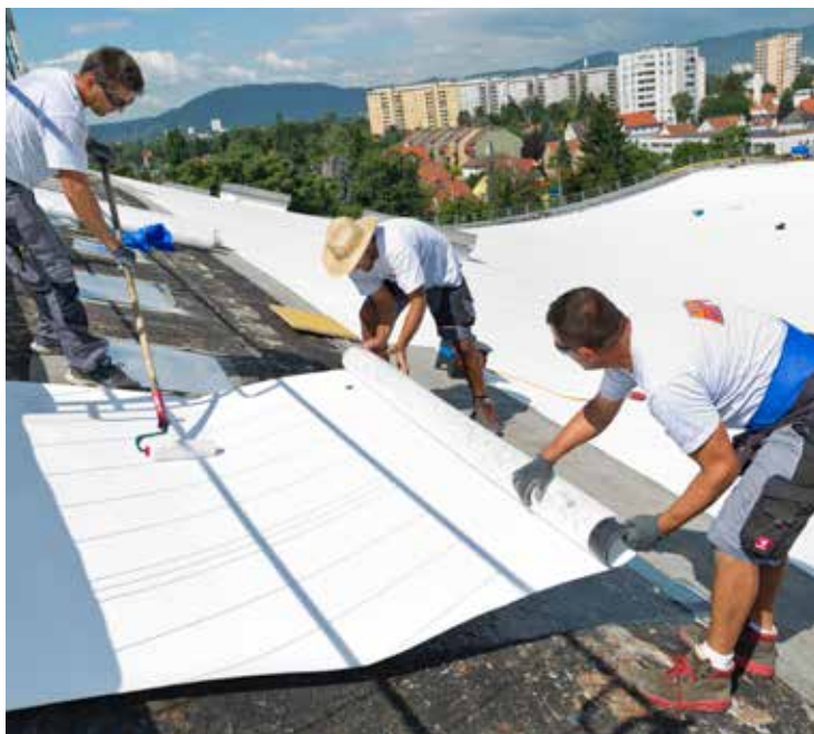
Bild 4: Anpressen der vlieskaschierten Dachbahnen
