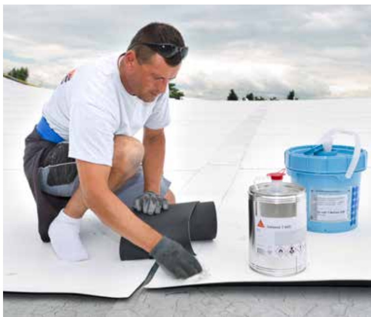
Bild 6: Stirnseitiges Verschweißen mit Sarnafil TG 66-18 Streifen
