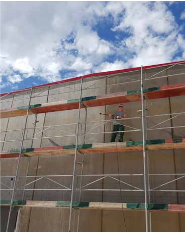
Bild 2: Grundierung der Wandfläche mit Sikagard®-552 W Aquaprimer
