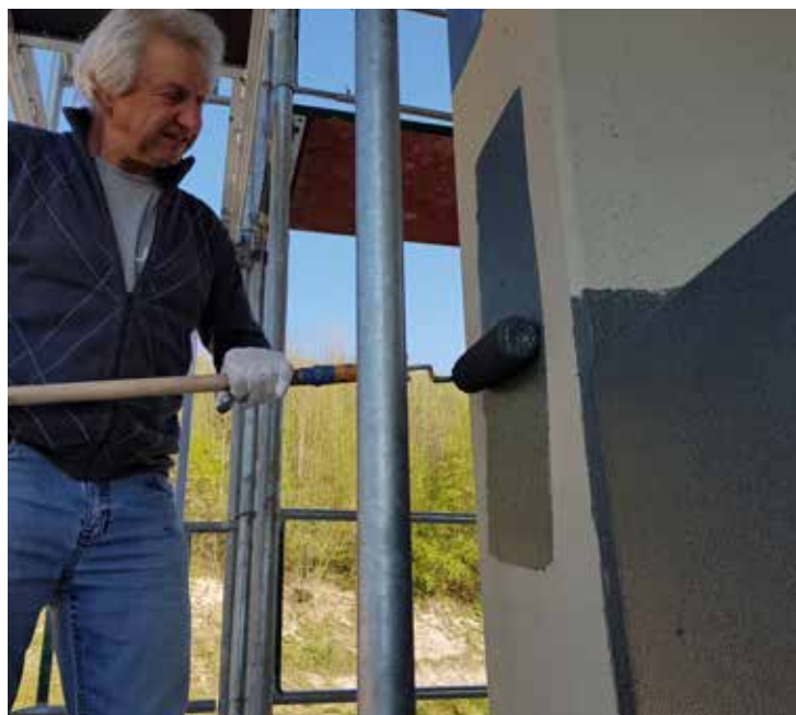
Bild 5: Einfacher Auftrag der Sika Produkte mittels Roller
