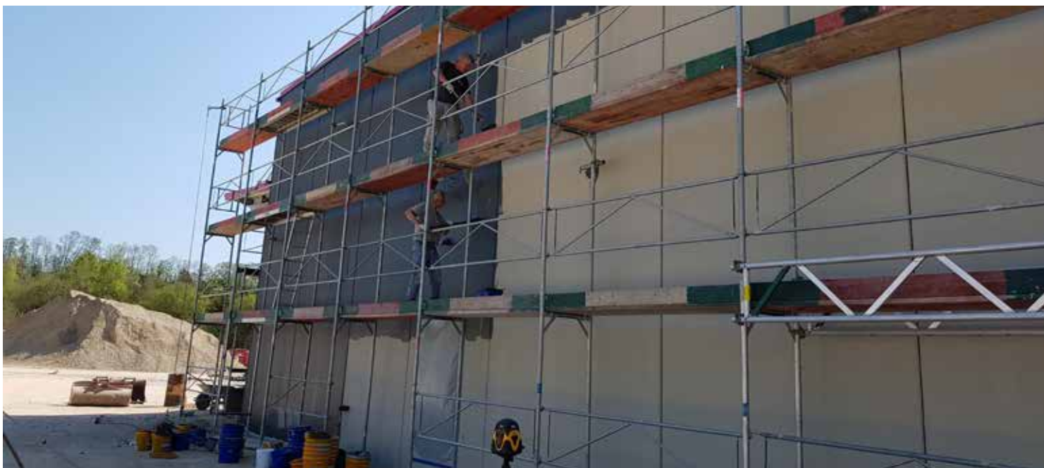
Bild 6: Finaler Anstrich mit Sikagard®-550 W Elastic als farbgebende Deckbeschichtung
