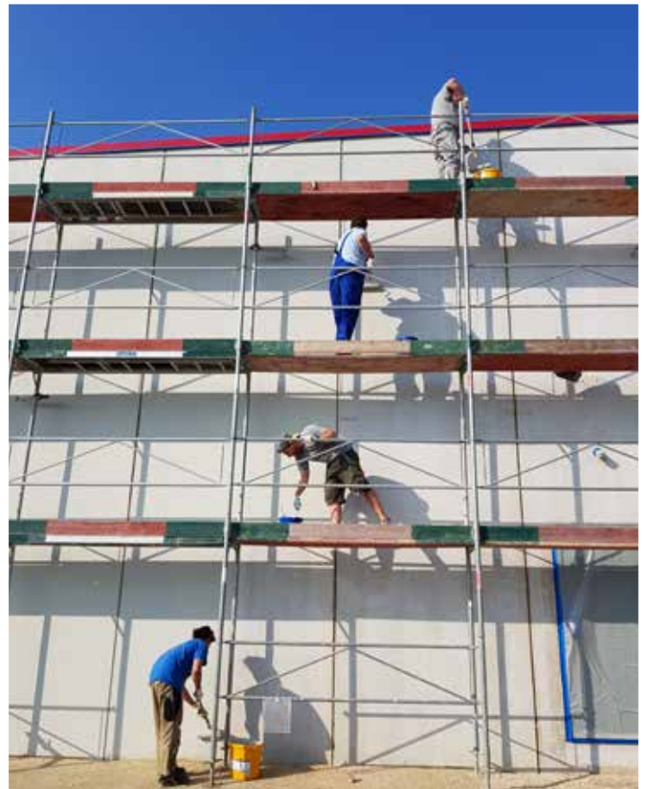
Bild 3: Füllbeschichtung mit Sikagard®-545 W Elastofill
