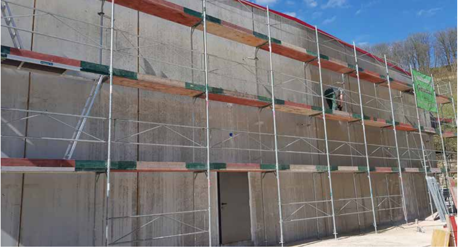
Bild 1: Nach Einrüstung der gesamten Wandfläche konnte mit der Sanierung der Fassade begonnen werden
