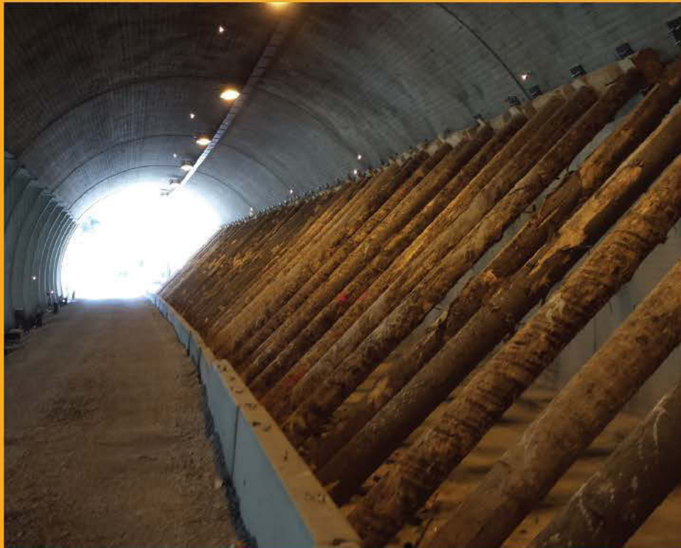
Stützarbeit: Das drückende Gerinne machte eine starke Abstützung der Galerie-Innenwand zwingend erforderlich
