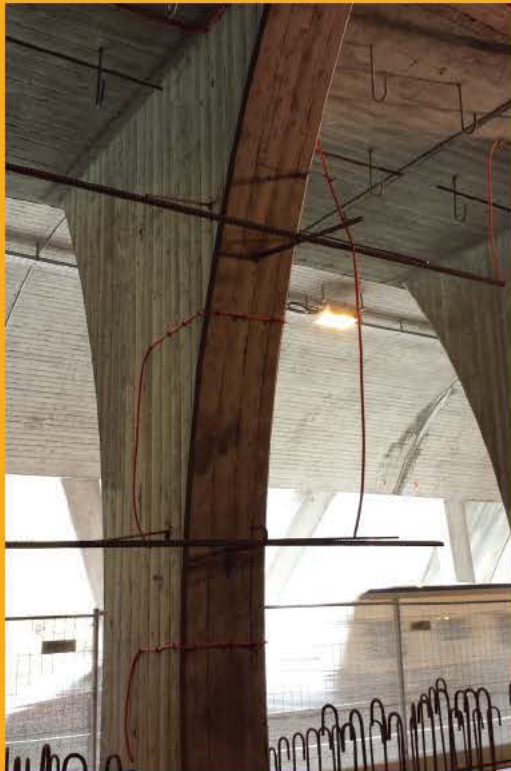
Injektion: Montage der Injektionsschläuche
