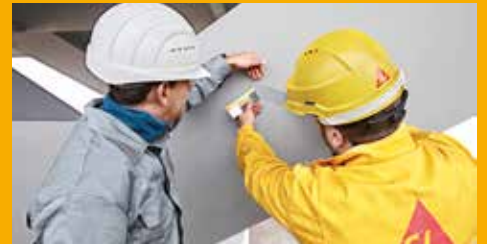
SERVICE UND BERATUNG AUF DER BAUSTELLE
