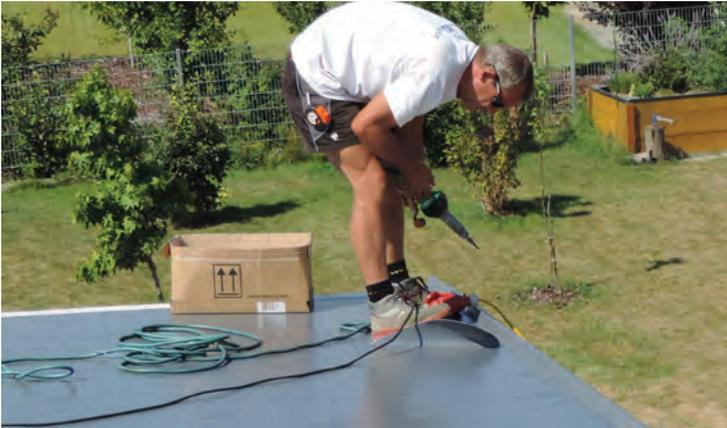
Die ausgerollten Bahnen werden an die Verbundbleche angeschweißt.
