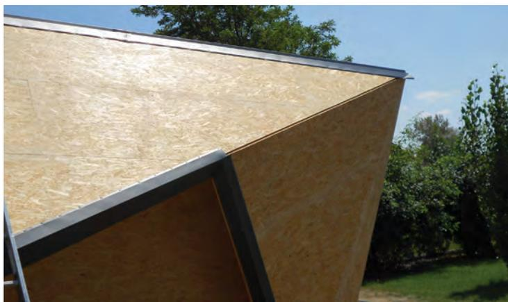
Der vorgefertigte Baukörper steht, die Verarbeiter beginnen mit der Verblechung der Kanten.
