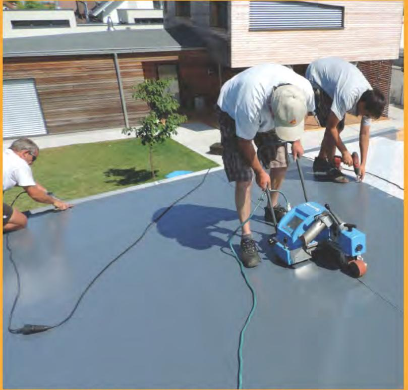
Befestigung, Verschweißung der Überlappung und Randanschluss im Teamwork
