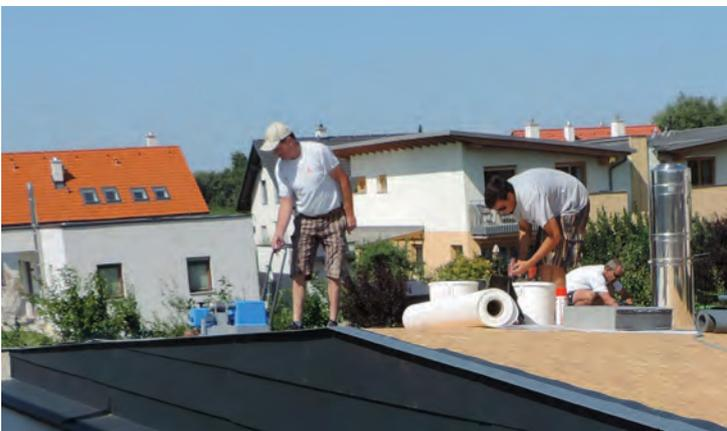
Die Verlegung der Abdichtungsbahnen bei warmen Temperaturen bringt den Vorteil, dass sich die Abdichtungsbahnen bei Temperaturunterschieden und den daraus resultierenden Wärme- und Kältekontraktionen faltenfrei auf dem Baukörper liegen.
