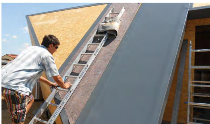
Die Abdichtungsbahnen werden sehr sorgfältig ausgerollt - dabei wird darauf geachtet, dass alle Bahnen in die gleiche Richtung laufen, um optische Irritationen durch unregelmäßig erscheinende Oberflächenprägung zu vermeiden.
