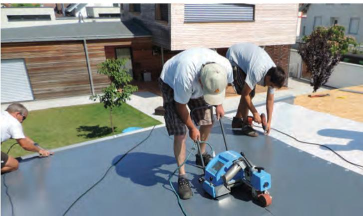
Lediglich auf der Dachfläche kann mit dem Sarnafil® Schweißautomaten gearbeitet werden.
