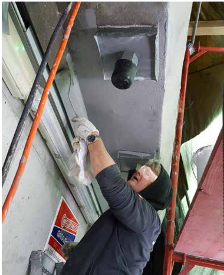
Bild 5: Abdichten der Betonoberfläche zwischen und rund um die Liftmechanik mittels Sikafloor®-359
