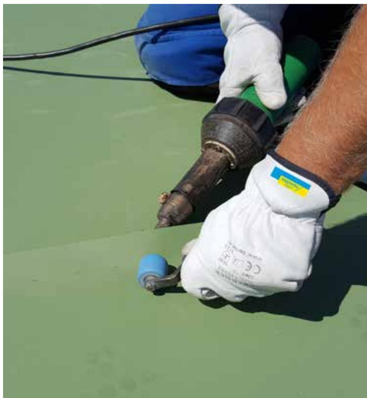
Bild 7: Keine offene Flamme bei der Montage durch Heißluftverschweißung
