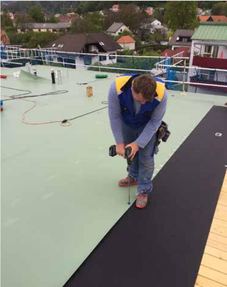
Bild 2: Fixierung der Kunststoffdichtungsbahn auf darunterliegenden Aufbau mittels SFS ISOFAST Kombi TS
