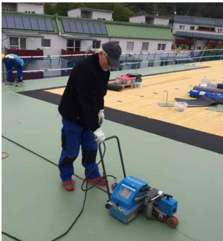
Bild 6: Mühelose und schnelle Verschweißung mit dem Sarnamatic® -681
