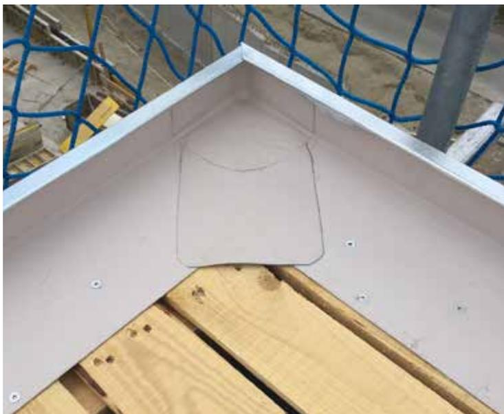
Bild 4: Passende Formteilecken erleichtern die Abdichtung
