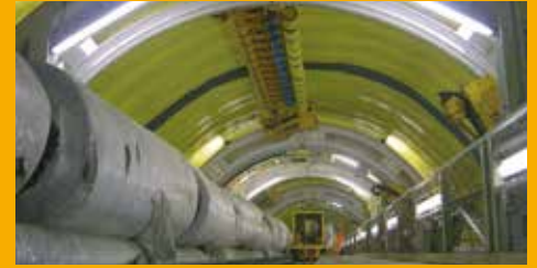
TUNNELBAU UND BAUWERKSABDICHTUNG
