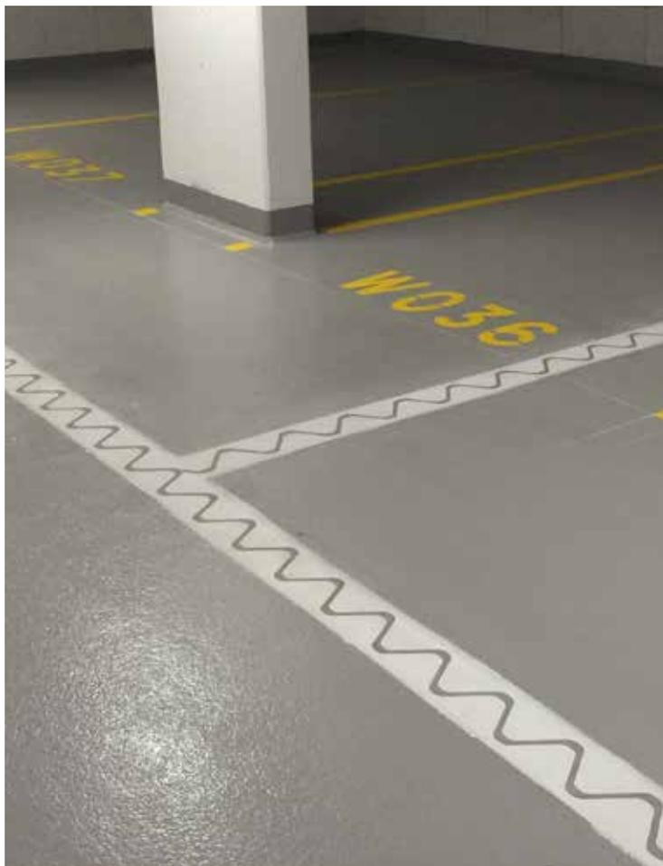
Bild 1: Planebene Fugenprofile gewährleisten den höchstmöglichen Fahrkomfort
