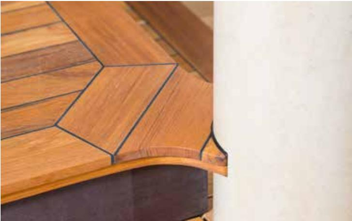
Bild 3: Anschlüsse wurden mit Sikaflex®-290 DC PRO sauber ausgearbeitet
