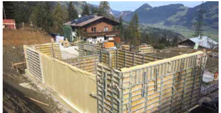
Bild 4: Abdichtung der Außenwände mit SikaProof® A
