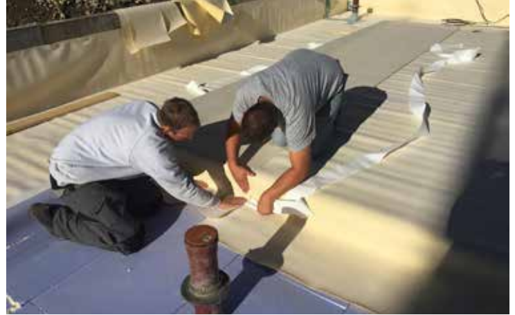
Bild 2: Abdichtung im Bodenbereich und bei Höhenversprüngen
