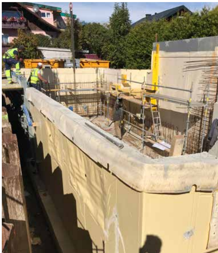
Bild 1: Dauerhafte Abdichtung der Kelleraußenwände (ca. 350 m 2 ) durch das SikaProof® A Abdichtungssystem
