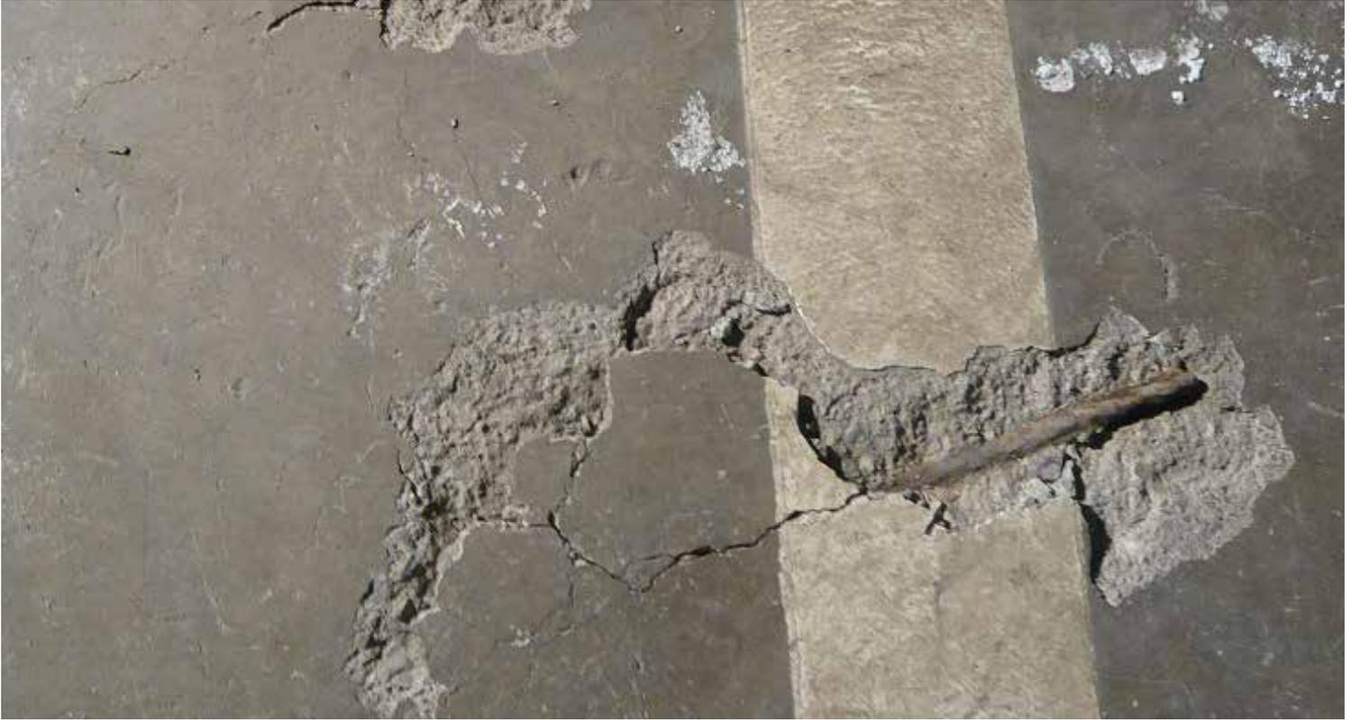
Bild 1: Betonaufbrüche und korrodierte Armierungseisen mussten instandgesetzt werden
