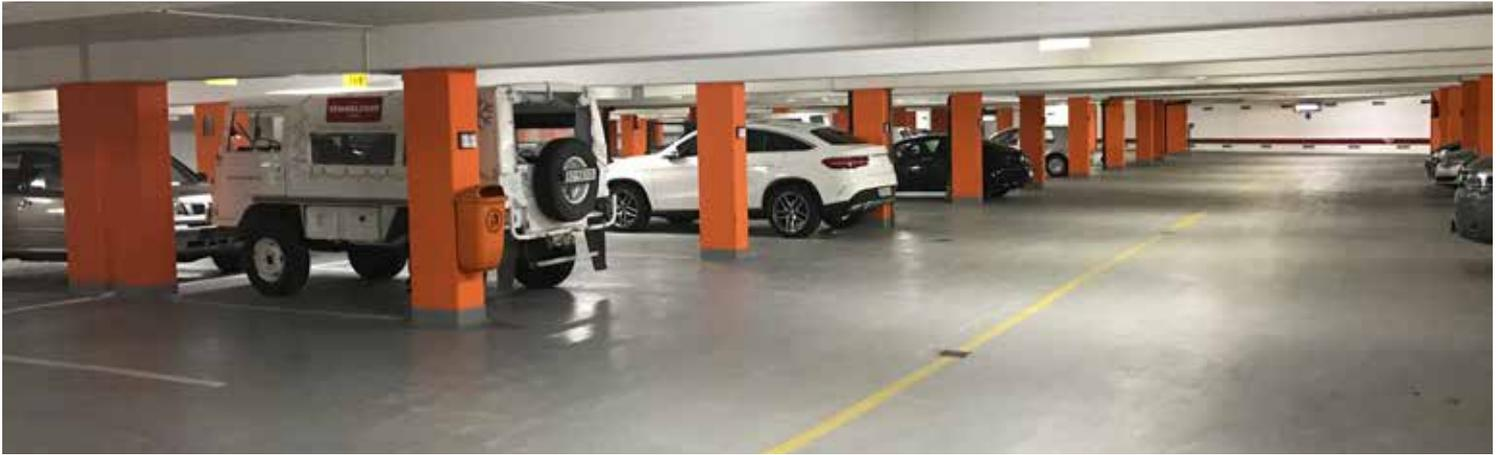
Bild 7: Durch farbliche Gestaltung bei dem technisch notwendigen Karbonatisierungsschutz erhielt die Tiefgarage ein neues Ambiente
