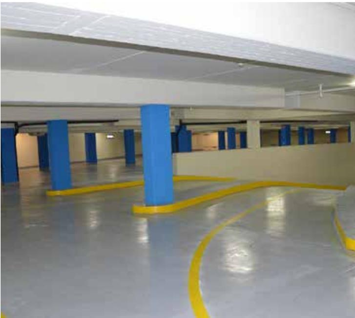
Bild 5: Decken und Wände wurden mit CO<sub>2</sub>-bremsenden Anstrichen versehen
