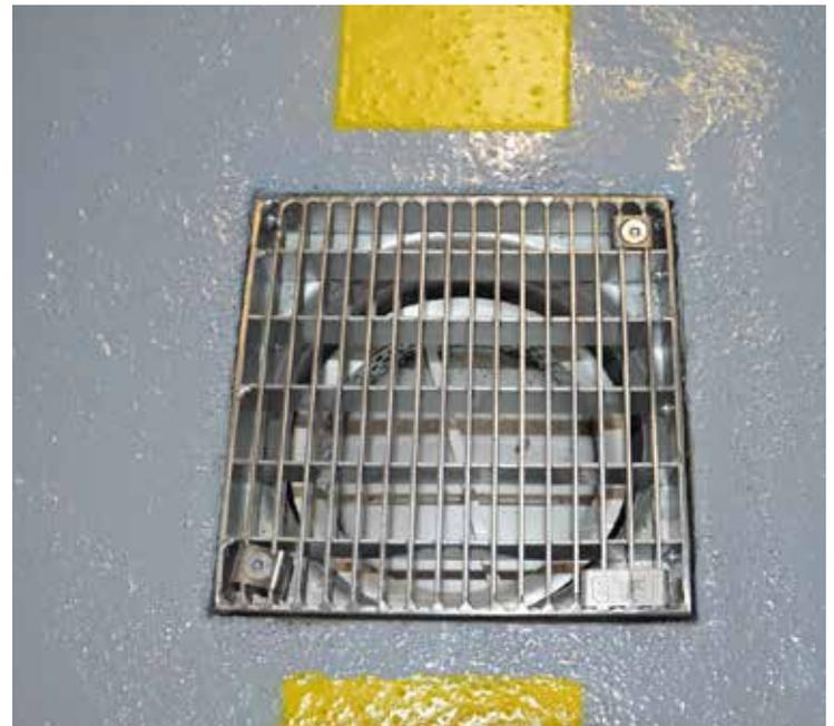
Bild 6: Die Ableitung des anfallenden Wassers erfolgt über eingebaute Gullys
