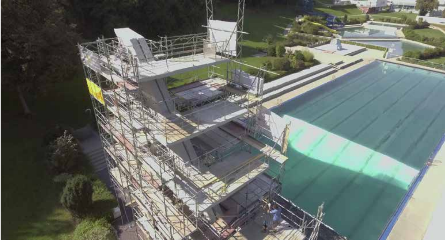
Bild 1: Das 50-m-Sportbecken mit seinem 10 m hohen Sprungturm bilden das Herzstück des Freibades in Steyr
