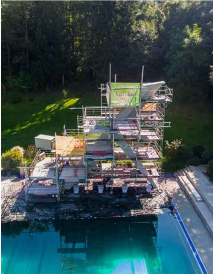
Bild 2: Der unter Denkmalschutz stehende Turm wird generalsaniert
