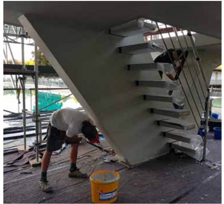
Bild 5: Sikagard®-545 W Elastofill ist im zweiten Arbeitsgang auch mit Wasser verdünnt rollbar
