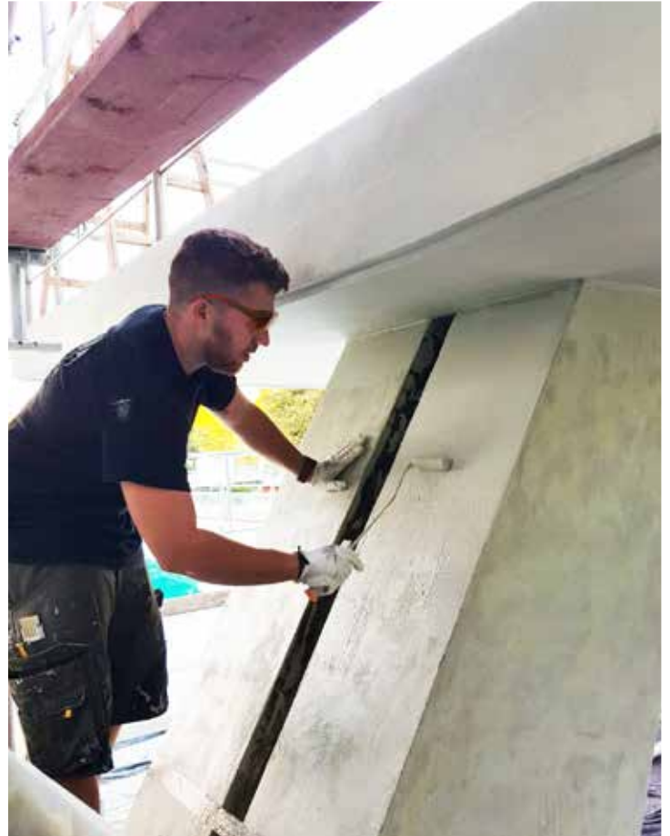
Bild 3: Sikagard®-552 W Aquaprimer wird als Grundierung aufgerollt
