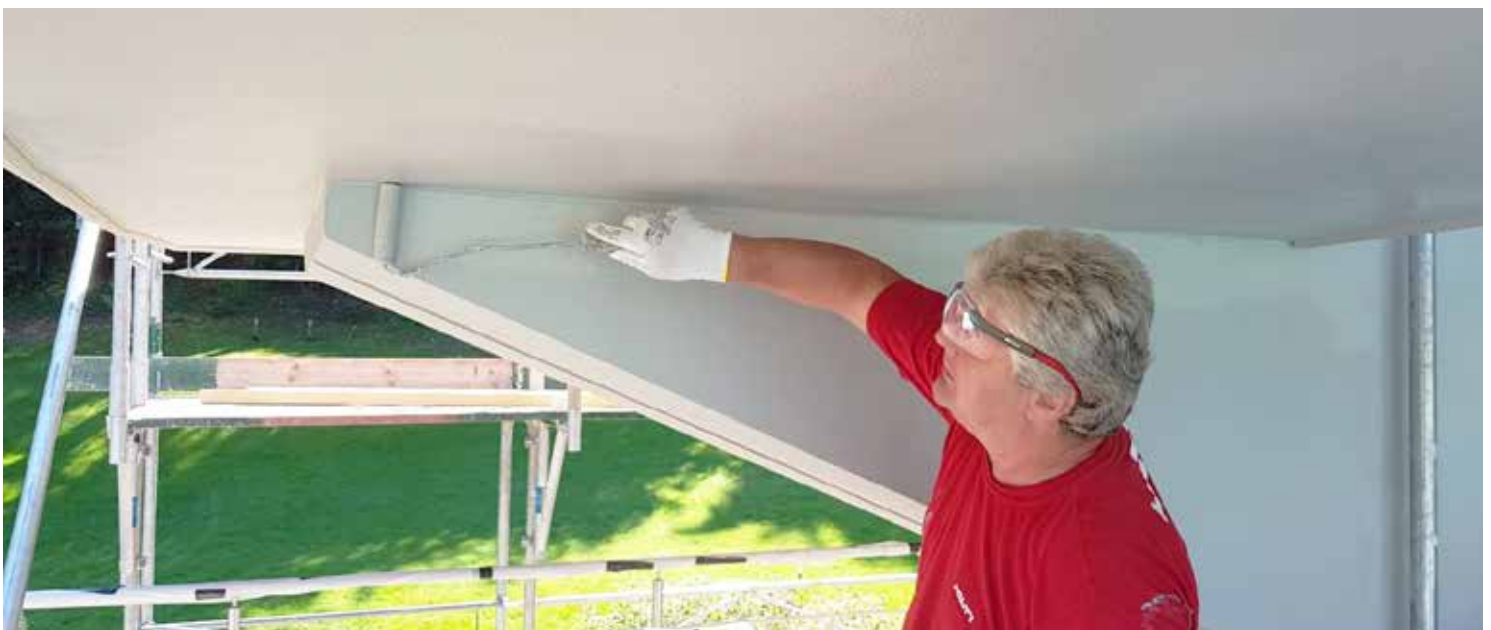
Bild 6: Sikagard®-550 W Elastic dient als rissüberbrückende Schutzschicht und zur Verschönerung von Betonbauteilen
