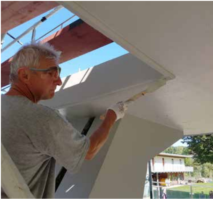
Bild 4: Sikagard®-545 W Elastofill wird als Porenverschluss angewendet
