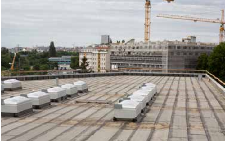
Bild 1: Rund 40.000 m 2 großes Dach des Smart Campus
