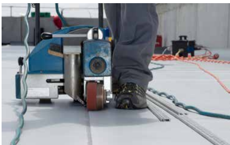
Bild 9: Verschweißen der Abdichtung mit dem Sarnamatic® Schweißgerät
