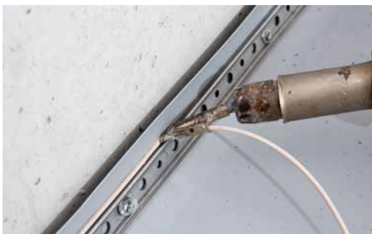
Bild 11: Befestigung der Randschiene mit hinterschweißter Rundschnur
