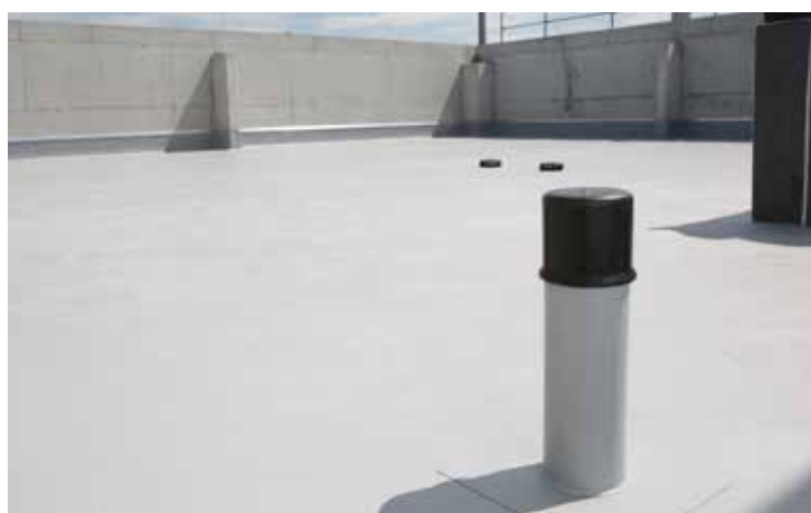
Bild 12: Fertige Teilfläche mit geklebten Wandanschluss und Kontrollrohrstützen
