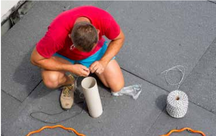
Bild 3: Einbau des Leckagenortungssystems
