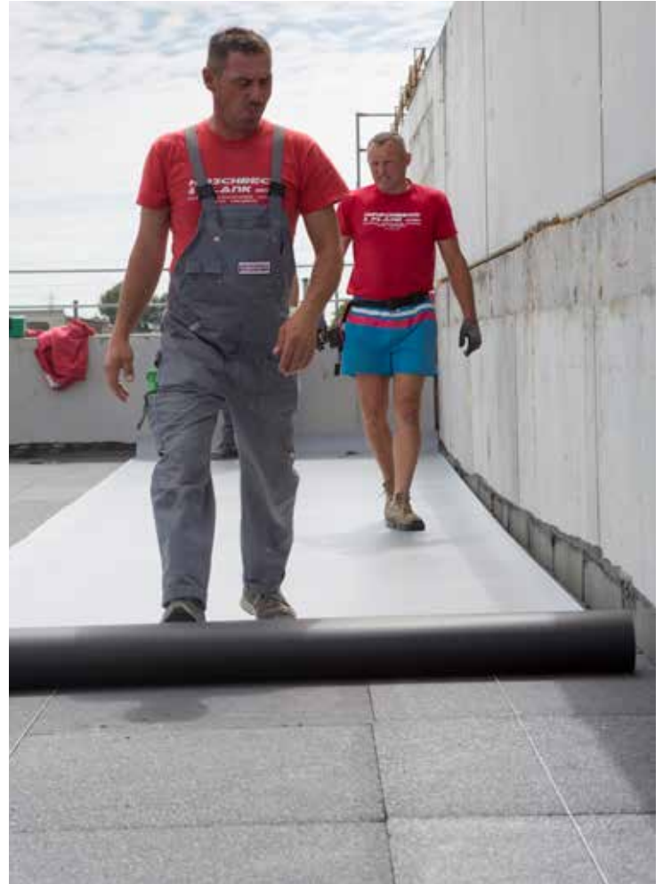
Bild 5: Ausrollen der Dichtungsbahn Sarnafil® TG 66-20, RAL 7040 fenstergrau
