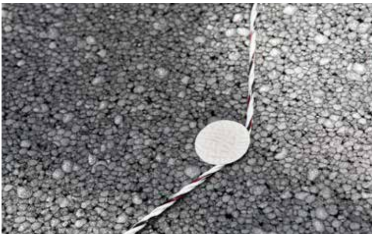
Bild 6: Anbringung der Geberleitung unter der Abdichtungsbahn
