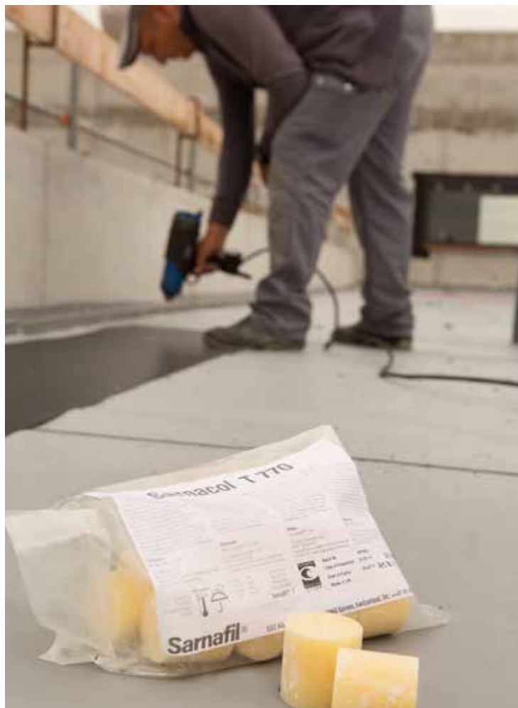
Bild 10: Verkleben der Attika mit dem emmissionsarmen Sarnacol T-770 Kleber
