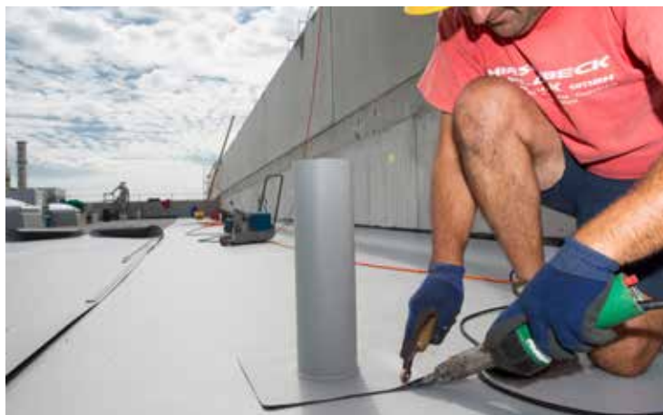
Bild 8: Verschweißen der Einfassungen mit einem Handschweißgerät
