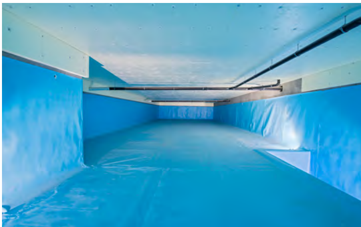
Bild 3: Fertig verlegte Sikaplan® WT 4220-15 C Felt Abdichtung
