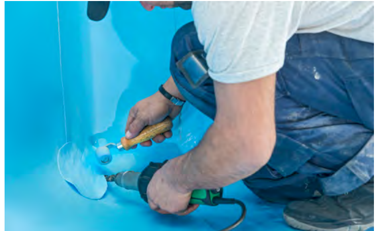
Bild 2: Details können ohne giftige Gase verschweißt werden
