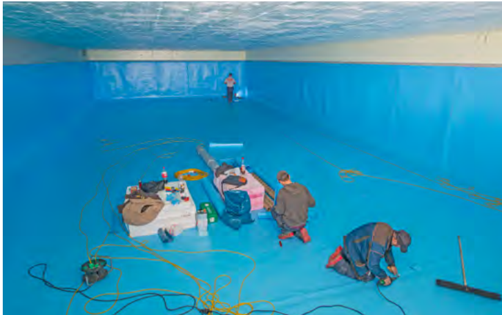
Bild 1: Arbeiten im geschlossenen Raum
