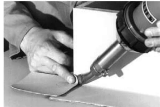
Die Flanken des vertikal aufstehenden Lappens mit dem **SikaPlan® WP / WT** Band verschweißen
