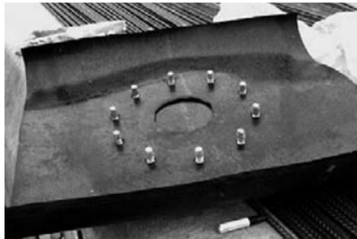
Eine Öffnung in die Abdichtungsbahn schneiden, passend zum Durchmesser der Durchdringung. Die vorbereiteten Abschnitte der Abdichtungsbahn, und die Abdichtungsringe, werden über den unteren Flansch gelegt und mittels Druckflansch fixiert. (Die Abdichtungsbahn darf unter den Abdichtungsringen keine Falten werfen, uneben aufliegen oder gefaltet werden).
