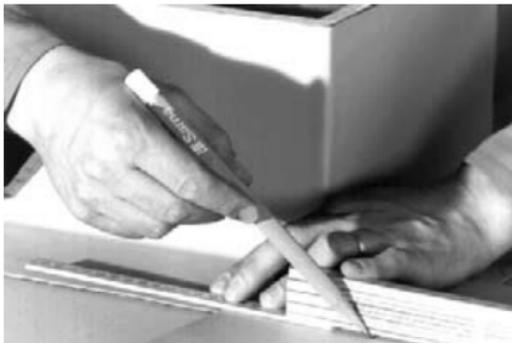
Das **SikaPlan® WP / WT** Überlappungsstück so zuschneiden, dass es mit der unteren Überlappung des **SikaPlan® WP / WT** Bandes übereinstimmt. Die ausspringende Ecke abrunden.
