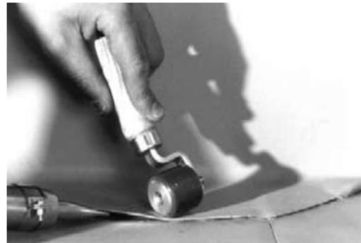
Die Überlappung mit der Abdichtungsbahn in der Dachfläche verschweißen. Die Schweißnähte erst nach dem Abkühlen mechanisch prüfen (Schraubenzieher mit Klingenbreite 5 mm).
