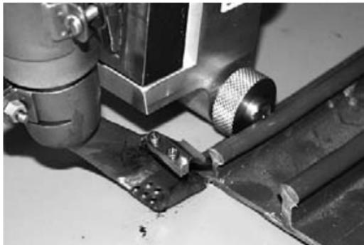
Die vorbereiteten Fugenbänder werden ausgelegt und so positioniert, dass die seitlichen Stöße mittels Leister Triac Drive verschweißt werden können.
