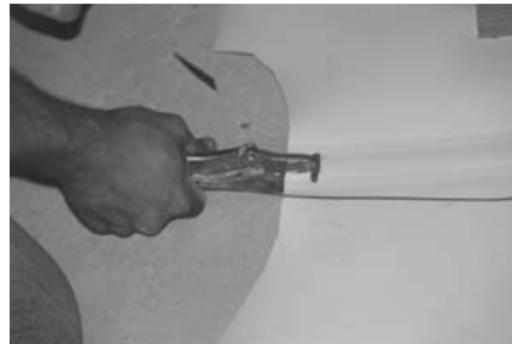
Schließlich wird das andere Ende der Naht mit einer Nahtklammer und dem Drucktest geprüft. Der anzusetzende Druck variiert entsprechend der Bahnentype und Bahndicke und liegt zwischen 1,5 – 2,5 bar.
