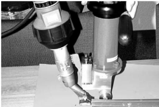
Verschweißen von Fugenbändern auf bereits installierte Abdichtungsbahnen mittels halbautomatischem Schweißgerät Leister Triac Drive:
