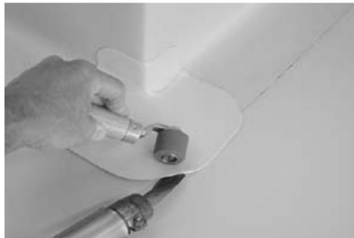
Das **SikaPlan® WP / WT** Formstück passend zuschneiden, mit einigen Schweißpunkten im Eck und in der Aufbordung fixieren und auf die **SikaPlan® WP / WT** Abdichtungsbahn schweißen. Immer in der Ecke beginnen und nach aussen hin zuschweißen.
