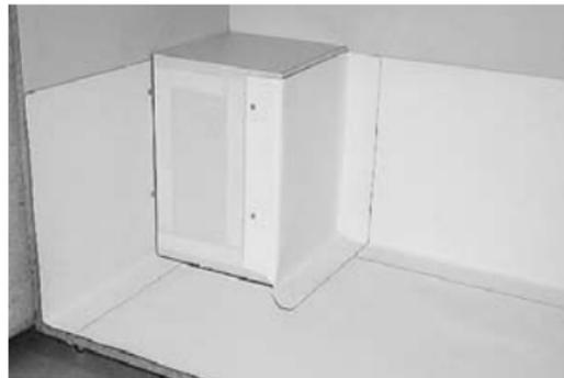
Die rechte Seite um die Ecke biegen und mit geeignetem Klebstoff oder Verschweißung auf das **SikaPlan® WP / WT** kaschierte Blech (90°) befestigen.
