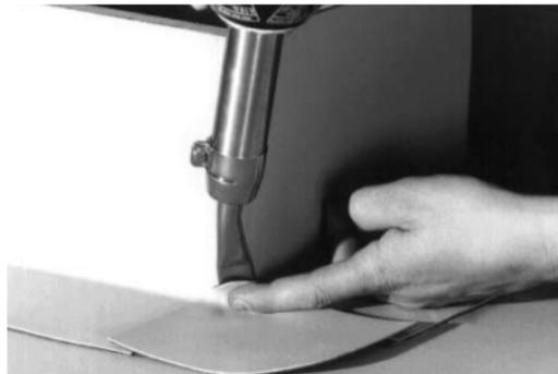
Den vertikal aufstehenden **SikaPlan® WP / WT** Lappen im Kantenbereich von unten nach oben aufschweißen.
