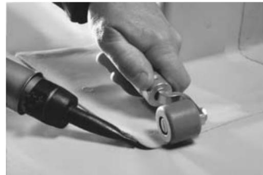
Für eine optimale Verschweißung muss darauf geachtet werden, dass sich der gesamte Luftauslassquerschnitt innerhalb der Schweißnahtüberlappung befindet.
