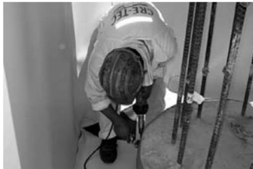
Die obere Ebene des Pfostensockels sollte nicht über das Fugenband hinaus ragen. Die Bewehrung laut technischen Spezifikationen ausführen.
