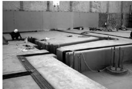
Vor allen weiteren Arbeiten müssen die verschweißten Fugenbänder auf ihre Wasserdichtigkeit geprüft werden.
