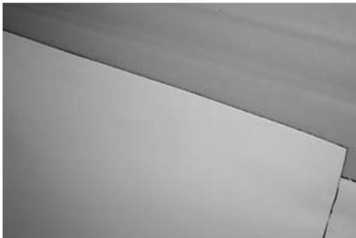
Um die **SikaPlan® WP** Abdichtungsbahn auf das **Sika® Fugenband** zu verschweißen, sind alle Verschmutzungen durch Beton oder Staub vom **Sika® Fugenband** zu entfernen.
