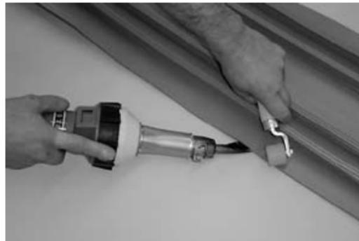
Das **Sika® Fugenband** vor- und anschließend fertigverschweißen. Sollte es notwendig sein, das **Sika® Fugenband** auf der Baustelle zu verlängern, so muss die Verschweißung mit der **SikaPlan® WP** Abdichtungsbahn ca. 50 cm vor dem Ende des Fugenbandes stoppen.
