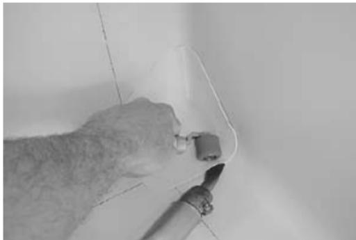
Das **SikaPlan® WP / WT** Formteil positionieren und auf die **SikaPlan® WP / WT** Abdichtungsbahn aufschweißen. Immer in der Ecke beginnen und nach aussen hin fertigschweißen.
