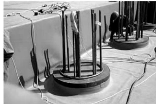
Nach dem Ausschalen muss die Oberfläche des Fugenbandes gereinigt werden (frei von ausgehärtetem Zement, Öl oder anderen Verunreinigungen). Danach die Abdichtungsbahn mittels Heißluft auf das Fugenband aufschweißen.
