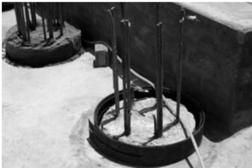
Aufbau der Schalung um einen Pfostensockel im Bereich der Bodenplatte. Das **Sika® Fugenband** (PVC bzw. FPO, auf einer Seite profiliert) mit der glatten Seite rund um die Schalung aufstellen.
