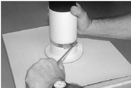
Die Ummantelung über das Rohr ziehen und kurzzeitig mittels Rohrschelle fixieren.
