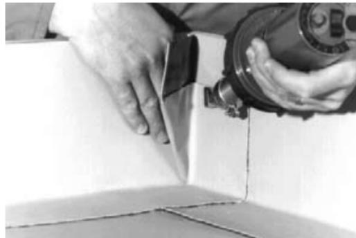
Die in sich zusammenschweißte Tasche – vom vertikalen Eckbereich aus beginnend – wasserdicht mit dem **SikaPlan® WP / WT** Anschluss verschweißen (Vor- und Fertigschweißung) und auch die vertikale Überlappungsnaht verschweißen.
