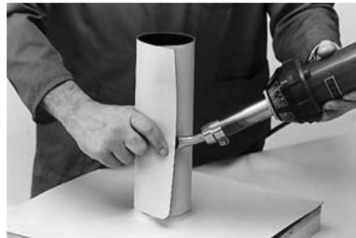
Die **SikaPlan® WP / WT** Rohrummantelung so zuschneiden, dass sie sich für die Ausbildung der Schweißnaht um 3 cm überlappt. Die Rohrummantelung satt anziehen und heften.
