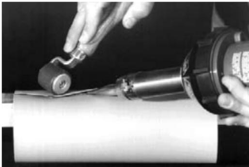
Die Ummantelung wird vorteilhaft über einer separaten Unterlage zusammenschweißt.
