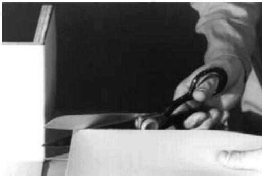
Das bei der Aussenecke noch fehlende, horizontale **SikaPlan® WP / WT** Überlappungsstück etwa 50 mm grösser zuschneiden und jene Ecke abrunden, welche an der vertikalen Kante zum Liegen kommt.
