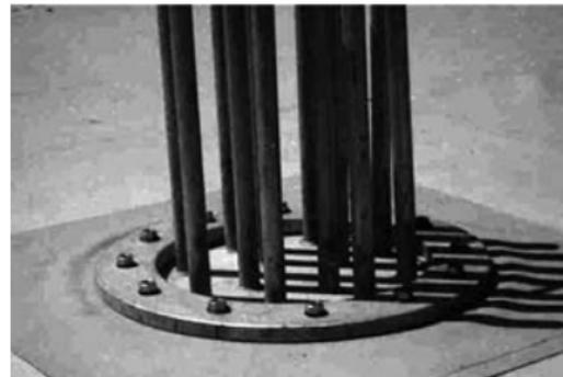
Den Abdichtungsring rund um die Durchdringung mittels Heißluft auf die Abdichtungsbahn verschweißen.
