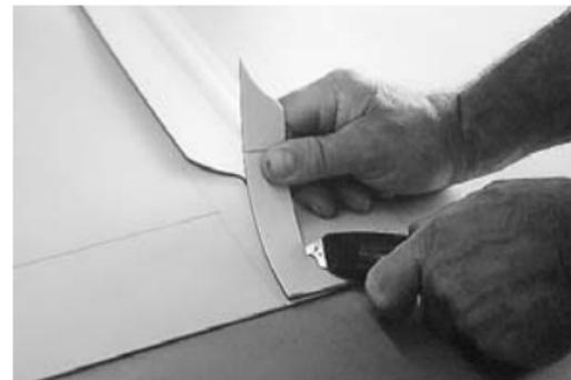
Mit einem Hakenmesser werden am Bahnenende ca. 20 cm der Überlappung von der oberen und der unteren Abdichtungsbahn abgeschnitten. Die Vorderkante der oberen Abdichtungsbahn wird mit dem Kantenhobel abgeschragt.
