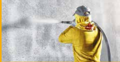
BETONSCHUTZ UND INSTANDHALTUNG
