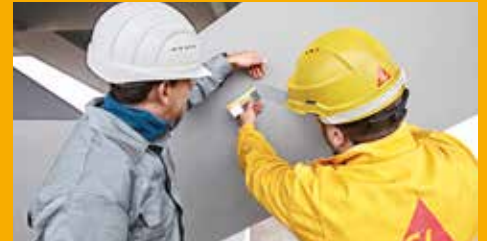
SERVICE UND BERATUNG AUF DER BAUSTELLE
