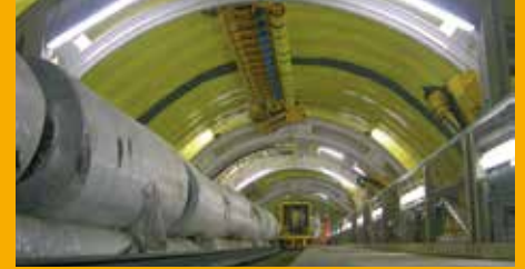
TUNNELBAU UND BAUWERKSABDICHTUNG
