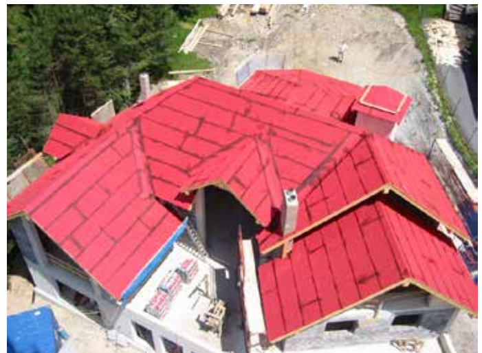
Detail Aufdachdämmung | Unterdach im Traufenbereich
