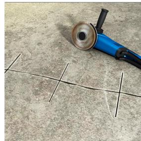
1. Rissflanken aufweiten und alle 15 - 20 cm quer einfräsen.
