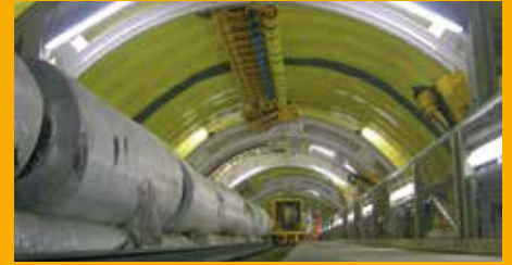
TUNNELBAU UND BAUWERKSABDICHTUNG
