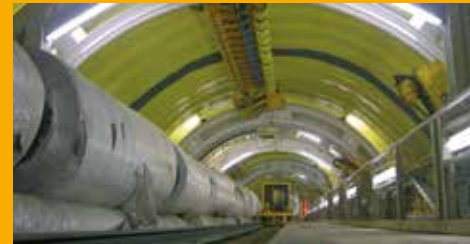
TUNNELBAU UND BAUWERKSABDICHTUNG
