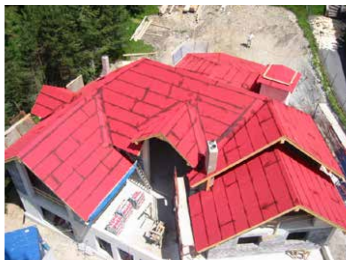
Detail Aufdach-dämmung | Unterdach im Traufenbereich
