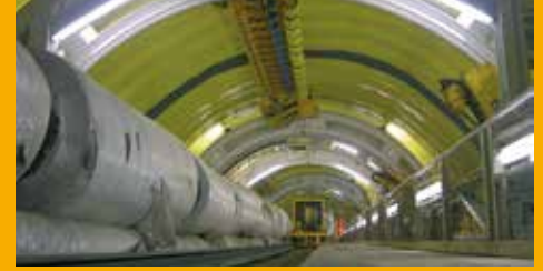
TUNNELBAU UND BAUWERKSABDICHTUNG
