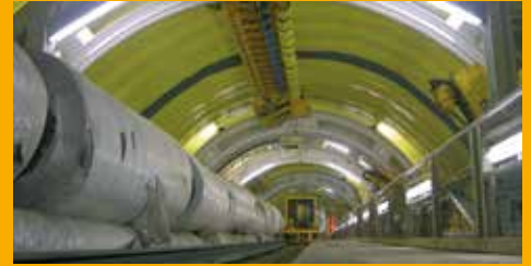
TUNNELBAU UND BAUWERKSABDICHTUNG
