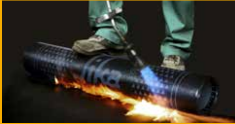
BITUMENABDICHTUNG
