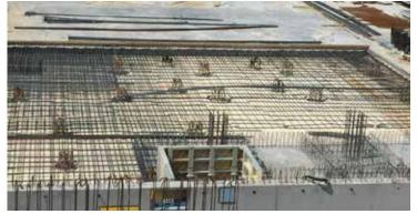
Bild 3: Abdichtung der Bodenplatte mit dem Frischbetonverbundsystem SikaProof® A
