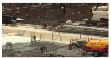
Bild 2: Einbindung der Bohrpfähle in das SikaProof® A Abdichtungssystem
