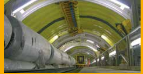
TUNNELBAU UND BAUWERKSABDICHTUNG
