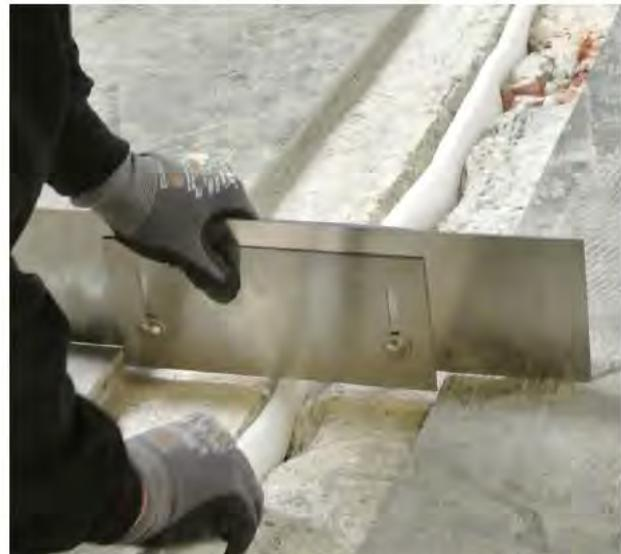
Höhenjustierung des Stopfprofils mittels einstellbarer Traufel.
