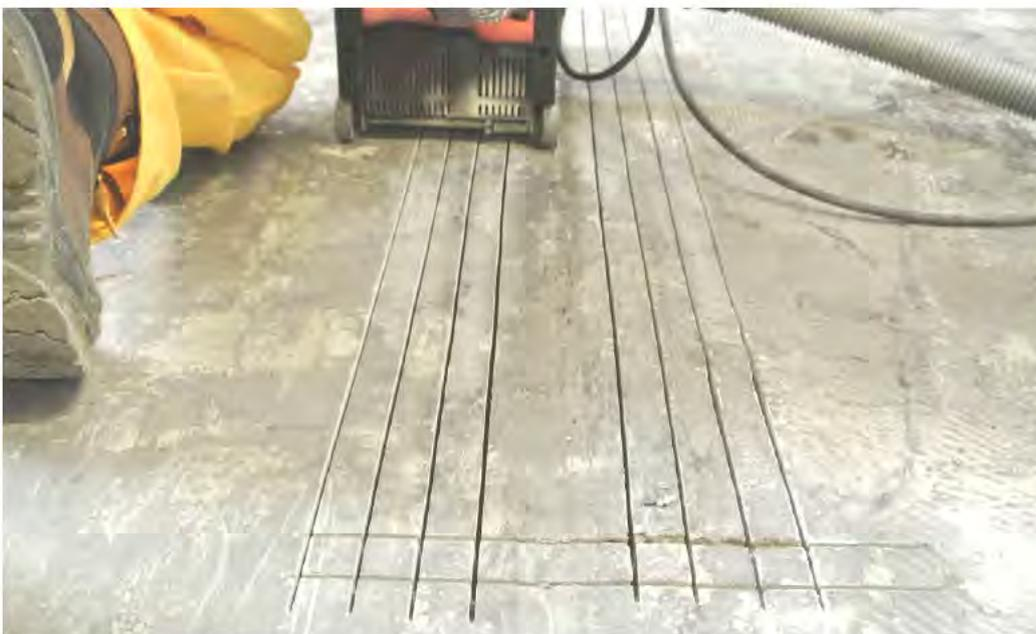
Nach dem Schneiden der Schlitze muss der Beton mittels Spitzhammer ausgestemmt werden. Geeignetes Werkzeug ist beispielsweise ein Hilti TE 70-AVR.
