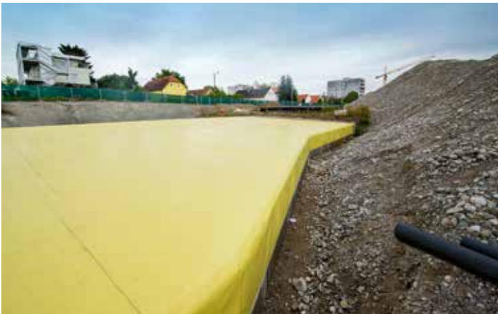
Bild 3: Abdichtung an Wand und Decke der Untertunnelung
