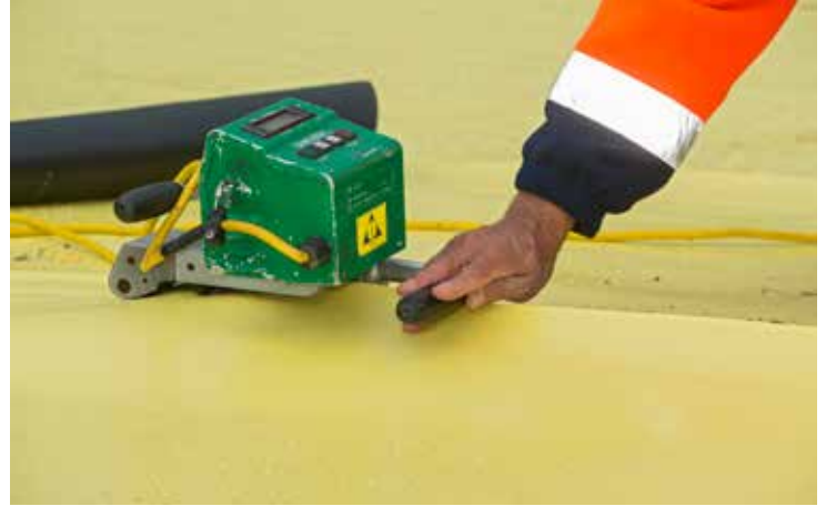
Bild 2: Horizontale Verschweißung mittels prüfbarer Doppelheizkeilnaht
