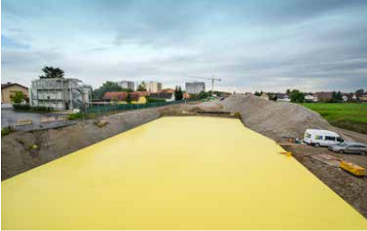
Bild 1: Sauber verlegte Folienbahnen Sikaplan® WP 1100-21HL2
