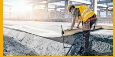
TUNNELBAU UND BAUWERKSABDICHTUNG
