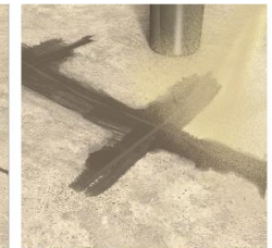
4. Überschüssiges Material verstreichen und anschließend mit Quarzsand Körnung 0,3 - 0,9 mm abstreuen.
