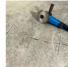
1. Rissflanken aufweiten und alle 15 - 20 cm quer einfräsen.
