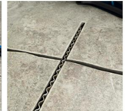
2. Wellenverbinder einlegen.
