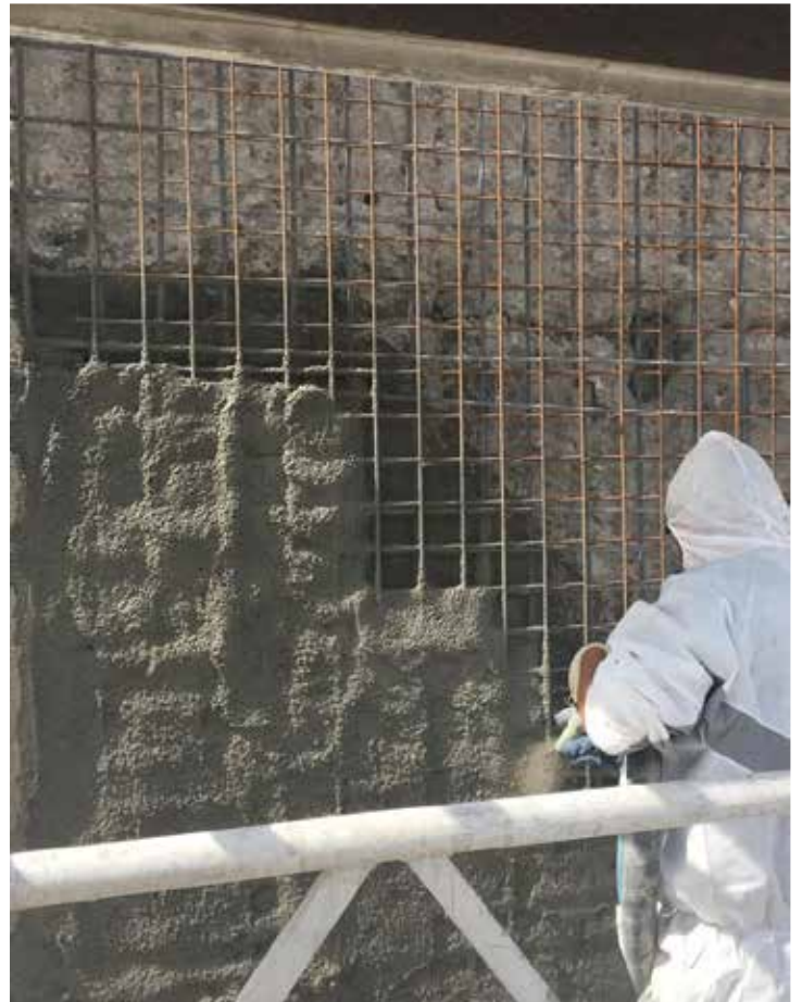
Bild 3: Die ausgezeichnete Haftung am Untergrund erleichtert die maschinelle Applikation
