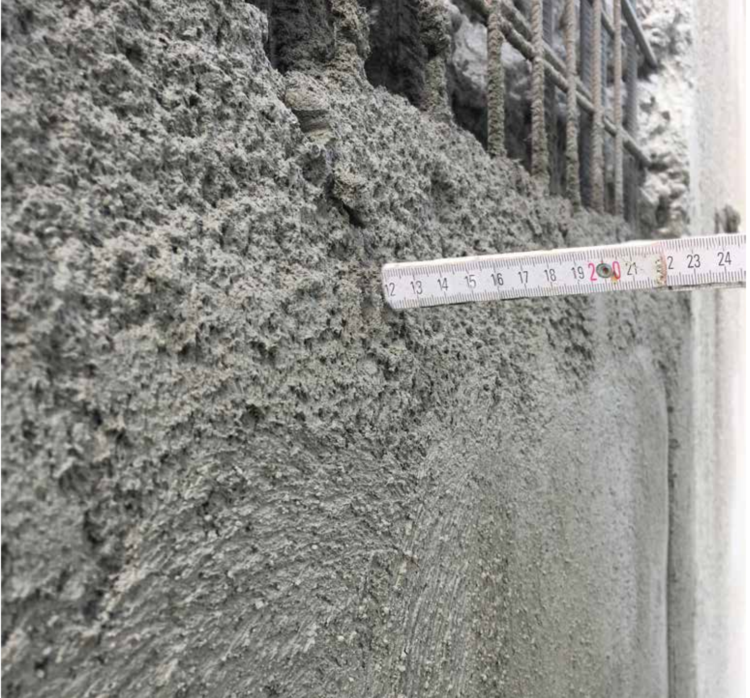
Bild 4: Ausgezeichnete Haftung am Untergrund (keine Haftbrücke erforderlich) ermöglicht das Applizieren von bis zu 12 cm in einem Arbeitsgang
