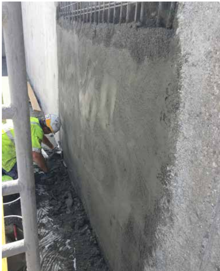
Bild 5: Nach der maschinellen Applikation wird Sika MonoTop®-412 Eco mittels Aluminiumlatte und Traufel abgezogen
