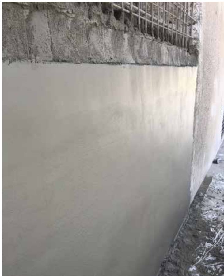
Bild 6: Nach dem Abziehen kann Sika MonoTop®-412 Eco ohne Wasserzugabe geglättet werden
