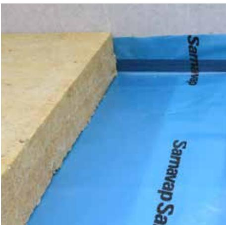
Auch bei sämtlichen An- und Abschlüssen sowie durchdringenden Bauteilen muss die Dampfsperrbahn warmseitig luftdicht auf trockene Untergründe angeschlossen werden.
