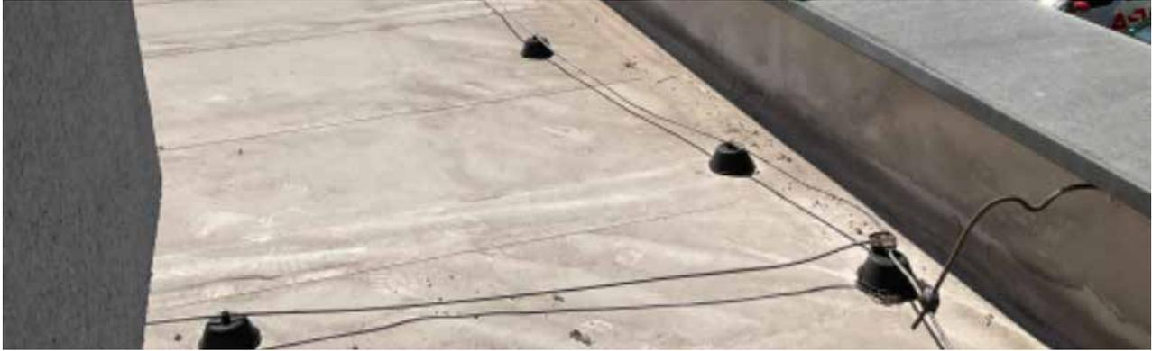
Im Zuge einer Dachinspektion wurde festgestellt, dass der Blitzschutzdraht nicht mehr ordnungsgemäß am Dach liegt. Ein typisches Beispiel das zeigt, wann nach der Dachinspektion eine Instandhaltung erforderlich ist.
