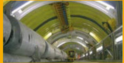
TUNNELBAU UND BAUWERKSABDICHTUNG
